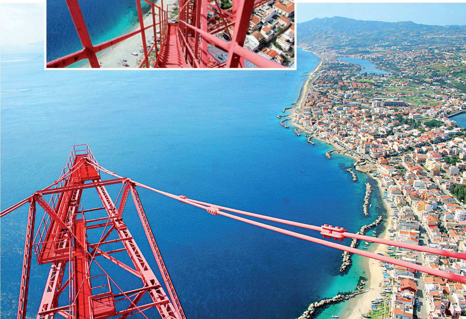
Torre Faro e Ganzirri (Messina) - Il luogo dove avrebbe dovuto sorgere il pilone siciliano del ponte
