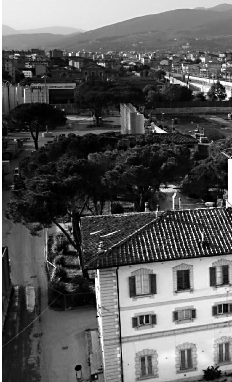
Firenze, zona Macelli - Il cantiere della stazione sotterranea
