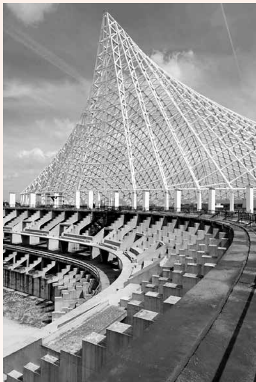
La Vela di Santiago Calatrava con i suoi 203 archi, a Tor Vergata Roma
